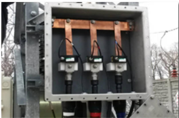
Εγκατάσταση HFCT στις ΕΞΩΤΕΡΙΚΕΣ ΠΕΡΙΟΧΕΣ, μέσα στο κιβώτιο γείωσης.
